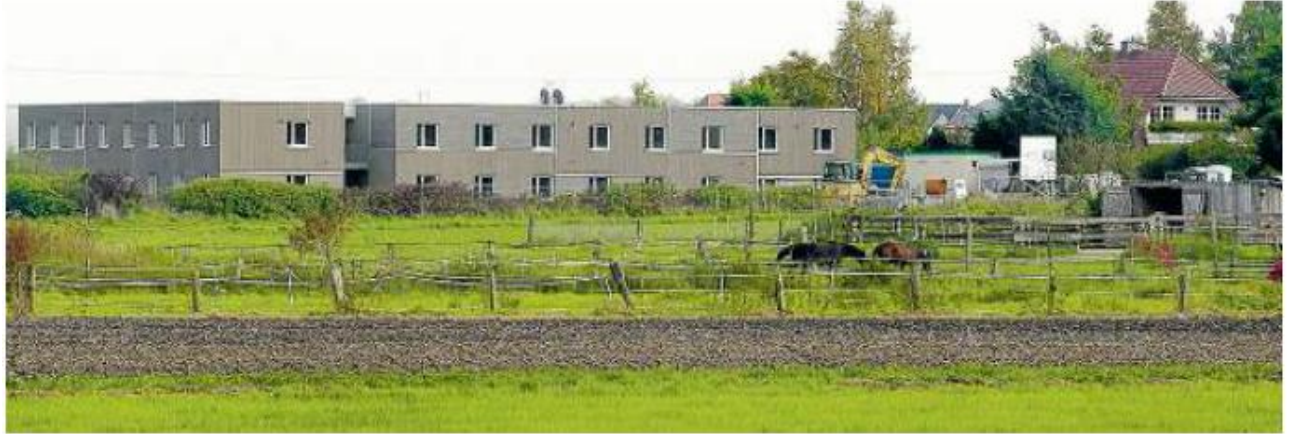
Der Neubau am Bruchstieg in Lamme ist schon weitgehend fertig.
